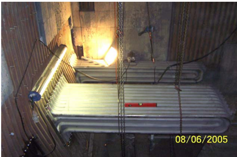
Bild 11: Tetratubes, eingebaut Quelle: Jacobs, Jens: Tetratubes; NEM Energy Services, 2005
